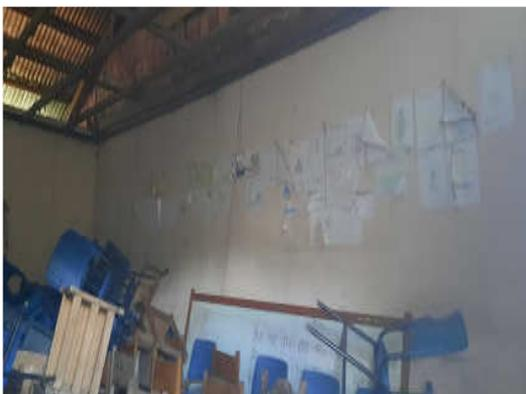
Foto 01: Vista interior da sala de aula, sem forro e com pintura danificada.
