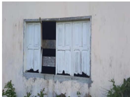
Foto 02: Janelas externas, totalmente deterioradas pela ação do tempo.
