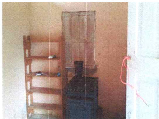
Foto 06: Vista área interna da sala da diretoria.
